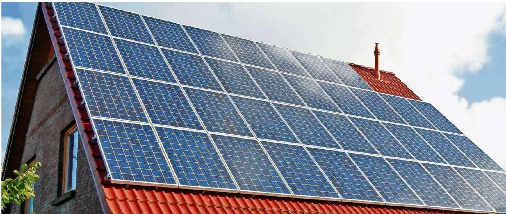
Das Schrägdach mit Giebel ist die in Deutschland am meisten verbreitete Dachform. Schrägdächer sind am besten für die Installation von Photovoltaik geeignet. Foto Ulich
