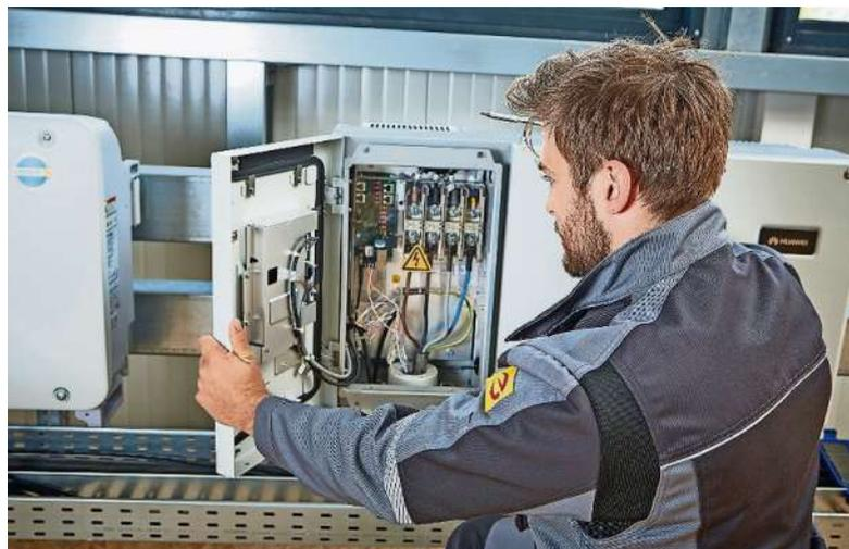
Wird eine Photovoltaikanlage installiert, muss der Elektroniker neue Verkabelungen im Haus vornehmen. Foto Lindemann/ArGe Medien im ZVEH
