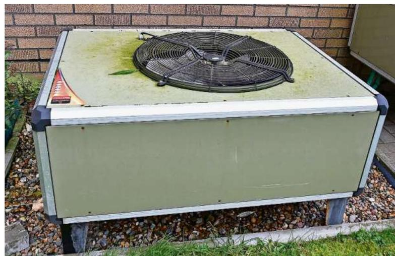
Die Bauweise einer Wärmepumpe ist zweigeteilt. Ein Bauteil steht draußen (Foto) und saugt die Luft an - im Heizungsraum steht ein Wärmetauscher und bringt die Wärme ins Heizungssystem. Foto Ulich
